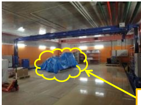
加速器導入・クレーン設置
