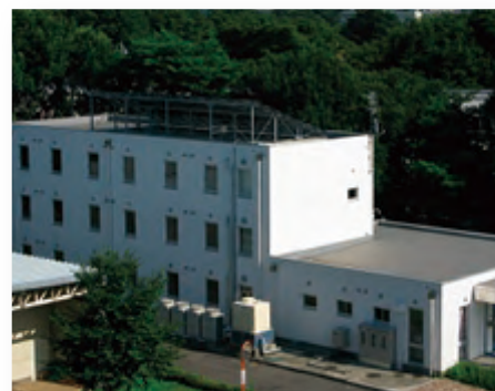
仁科ロッジの屋上に設置された太陽光発電パネル
